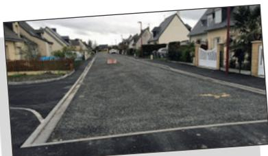
Rue des Grèves et de la Maraze pour la réfection des canalisations d'assainissement et la séparation des eaux usées et des eaux pluviales. Prélude obligatoire pour l'extension envisagée de la lagune d'Hirel.
